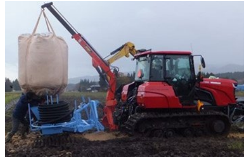
ウ. 水田の施工状況 (フレコンでモミガラ疎水材無人投入)
